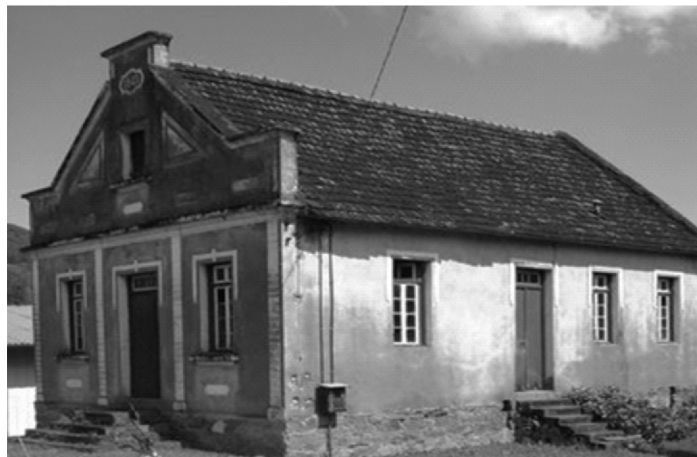
Figura 7 – Casa antiga do interior de São Lourenço do Sul.
