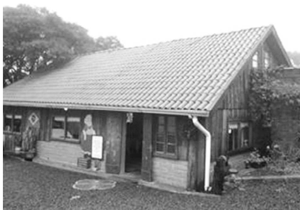
Figura 1 - Vista externa do Restaurante do Sítio.
