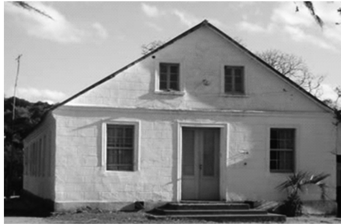
Figura 6 – Casa do colonizador do município de São Lourenço do Sul
