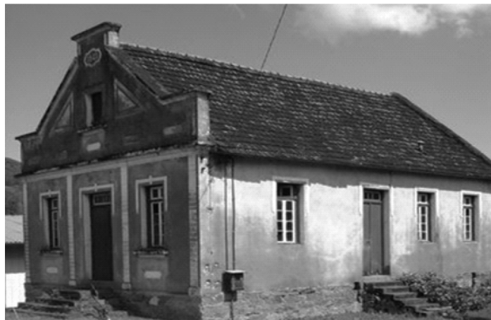
Figura 7 – Casa antiga do interior de São Lourenço do Sul.
