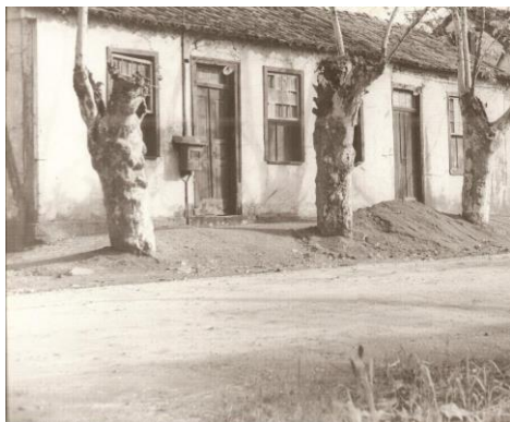
Figura 7 - Casa do Artesão antes do restauro
